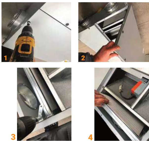
Wymiana filtra w modelu Flat 350 i 550 montaż pod sufitem
